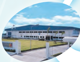
タイ工場 THAILAND OFFICE & FACTORY
