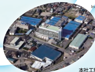
本社工場 HEAD OFFICE & FACTORY
